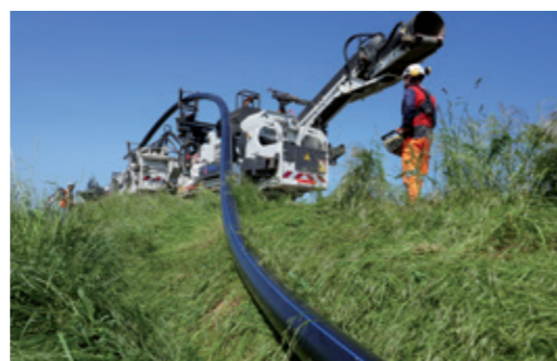
Pose mécanisée - crédit Elydan
