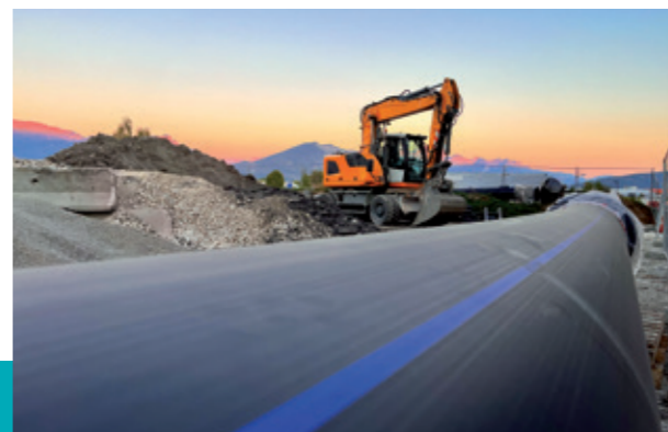
Pose mécanisée - crédit Elydan
