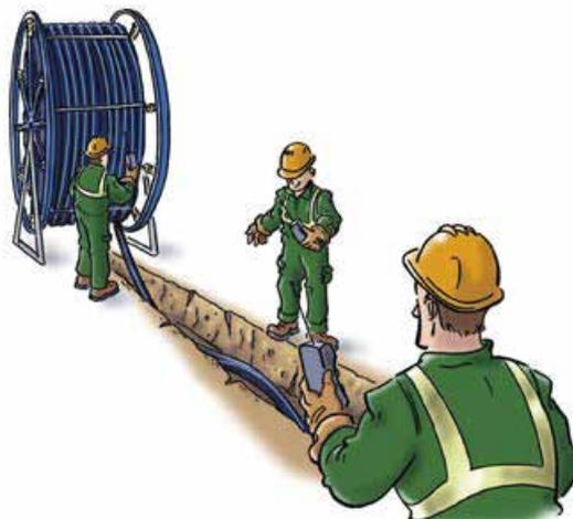
Les frottements sur le sol ou sur les bords de la tranchée seront évités par la mise en place de protections bois ou en matière plastique. L'emploi d'une goulotte de guidage facilite l'entrée en fouille.
